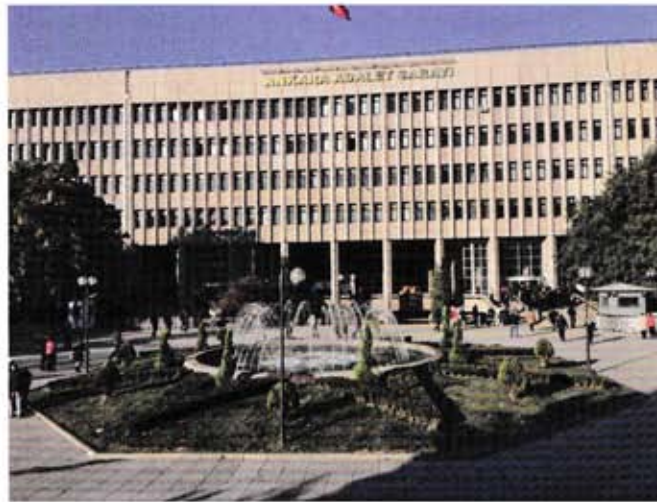
Das Gerichtsgebäude in Ankara
